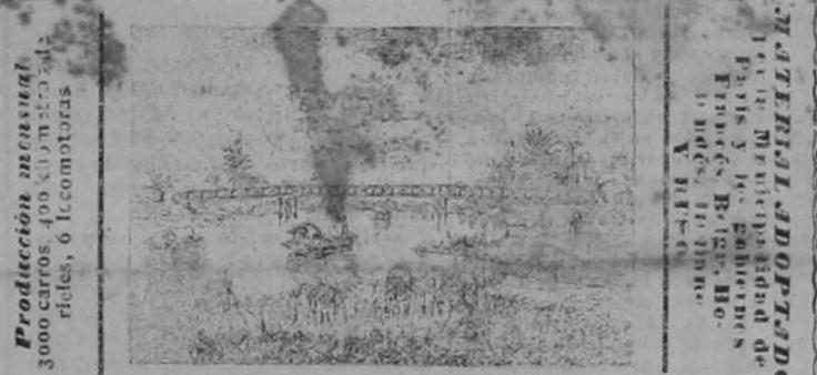
PUENTE DE 66 METROS EN DONG-NHYEN (Conchinchina) compuesto de 3 puentes de 22 metros, tipo 6 kts.
